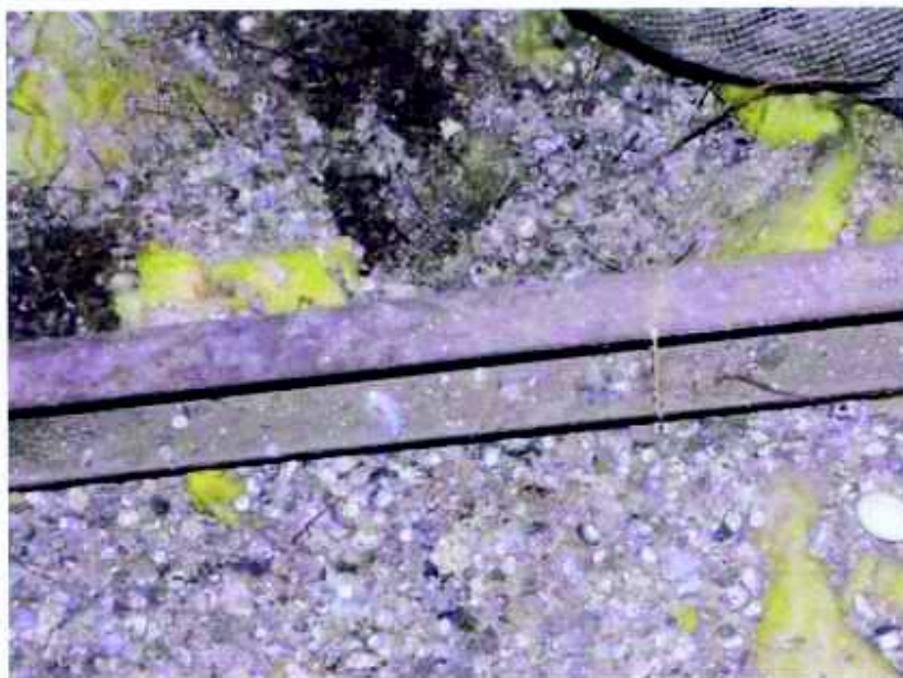
Foto 4. Odchody gołębi na poddaszu w części północnej
